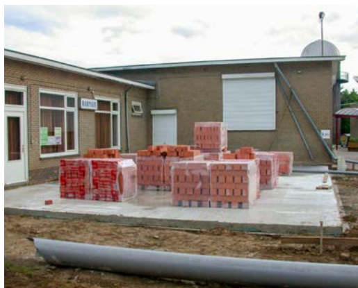
Bouw van de multifunctionele zaal en de tentoonstellingszaal, 2002
